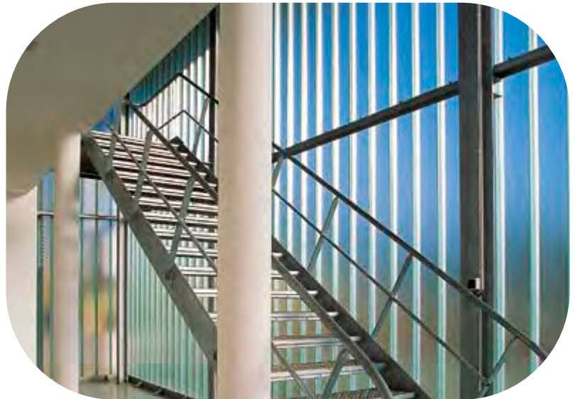
EDF Ställverk, Neuilly-sur-Marne, Frankrike. Pilkington Profilit™
